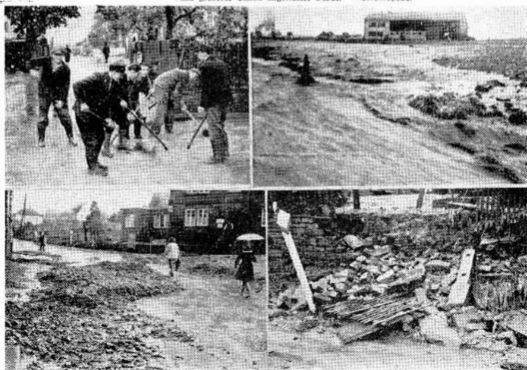
Unsere Aufnahmen von dem Unwetter am Sonntagnachmittag zeigen (oben links) Feuerwehrmänner in Niklashausen, die die Schlamm-massen von der Taubertalstraße fortschaffen, und A. Dosch (Mitte) aus dem Katastrophengebiet in und um Kilsheim. Vom Zigeunerstock her schossen die Wassermassen wie ein heftiger reißender Wildbach (oben rechts) in die Brunnenstadt. Auf den Straßen, wie unten links vor dem Postamt in Kilsheim, lagen hohe Geröllmassen und behinderten auch nach Stunden den Verkehr. Von den Sturzhängen wurden vielfach Mauern und Gartenzäune, (unten rechts, ebenfalls in Kilsheim) fortgerissen. Aufn. Dosch (3), Wendrich
