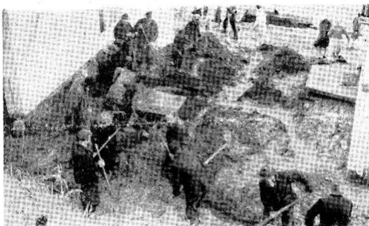
In Kilsheim richtete das Unwetter an einem Neubau am Fuße des Kattenberges starke Schäden an. Der Wasserstrom drückte an der Bergseite eine Mauer ein, strömte durch den Keller und das Schlafzimmer, wo es eine Glastüre durchbrach und sich einen Abfluß suchte. Unser Bild zeigt Männer beim Wegräumen des Schlammes und Gerölls um das Haus. Aufn. Dosch
