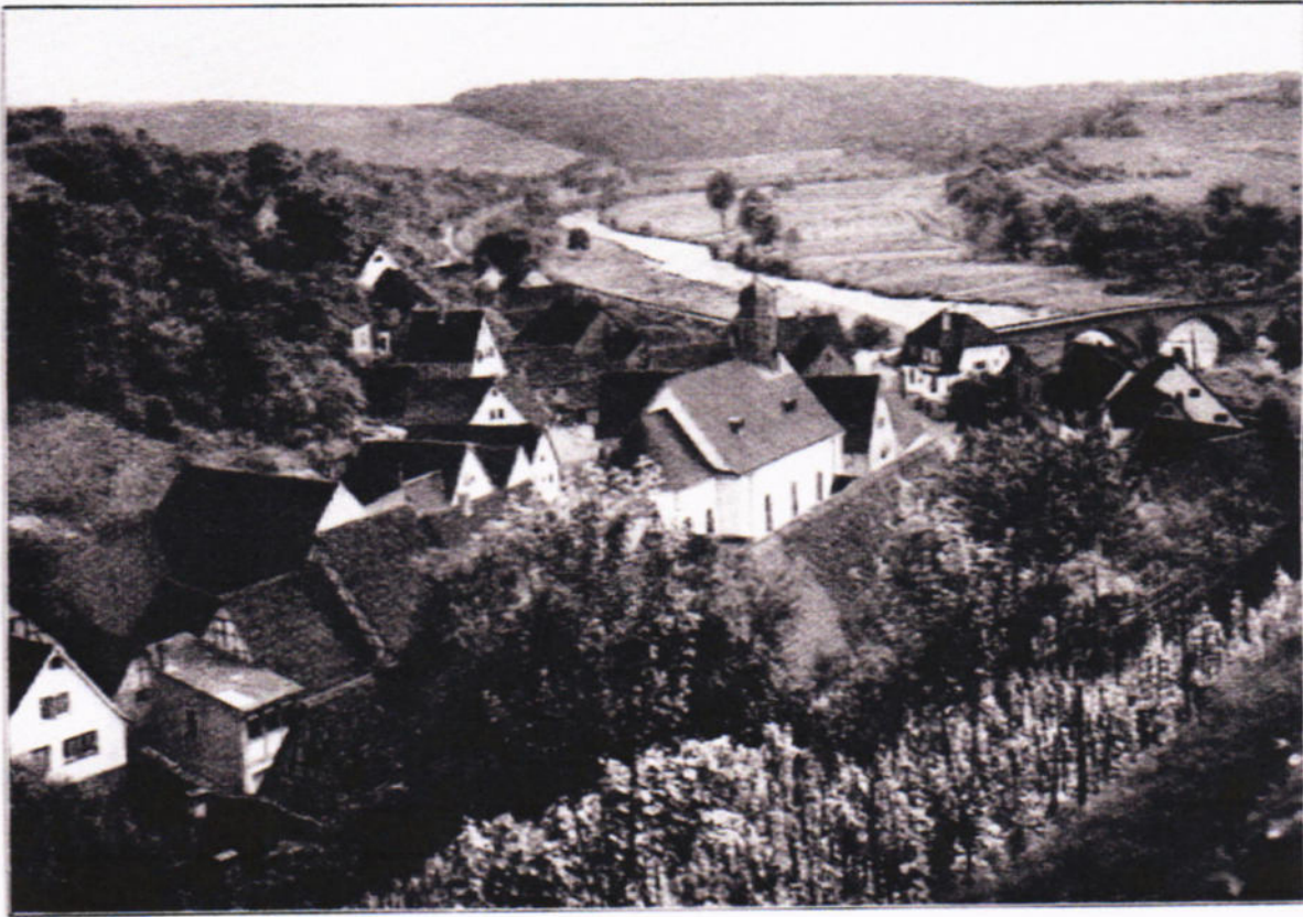
Jagstbrücke bei Herbolzheim
