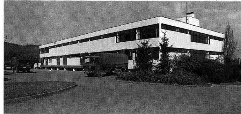
Lager- und Werkstattgebäude der Standortverwaltung Kilsheim
